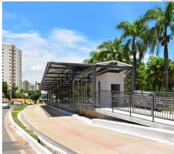
Obras do BRT Norte-Sul seguem: previsão é de início das operações em julho
